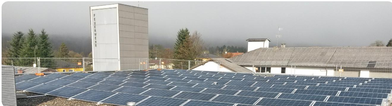
Auf dem Feuerwehrdach in Hörbranz, Heribrandstraße 18 hat die VKW in Zusammenarbeit mit der Marktgemeinde Hörbranz eine Fotovoltaikanlage mit 52,26 Kilowatt installierter Leistung (kWp) errichtet.
